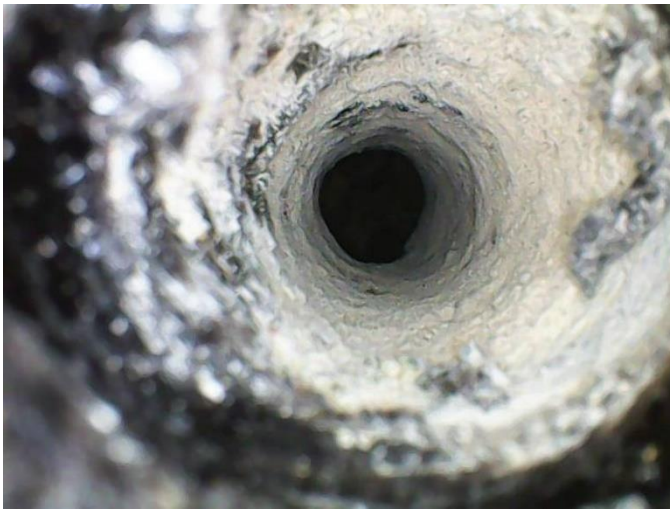
24 pav. Denginio sluoksnių tyrimas endoskopu, matomas cementinio skiedinio ir hidroizoliacijos sluoksniai.
