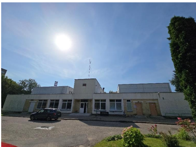
7 pav. Tiriamas pastatas iš šiaurės pusės.
