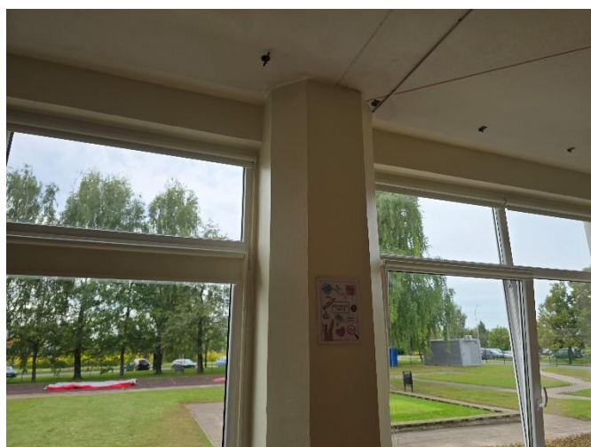
59 pav. Bendras išorinės kolonos vaizdas.
