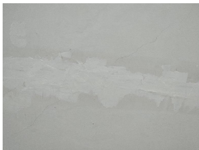
66 pav. Įtrūkimai trikampėje perdangos plokštėje.
