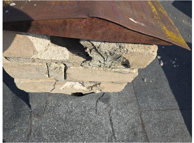
54 pav. Ištrupėjęs ir erozijos veikiamas kaminėlio mūras. Matomas koroduojantis apskardinimas.
